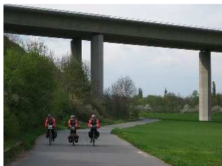
Radweg bei Dittigheim
